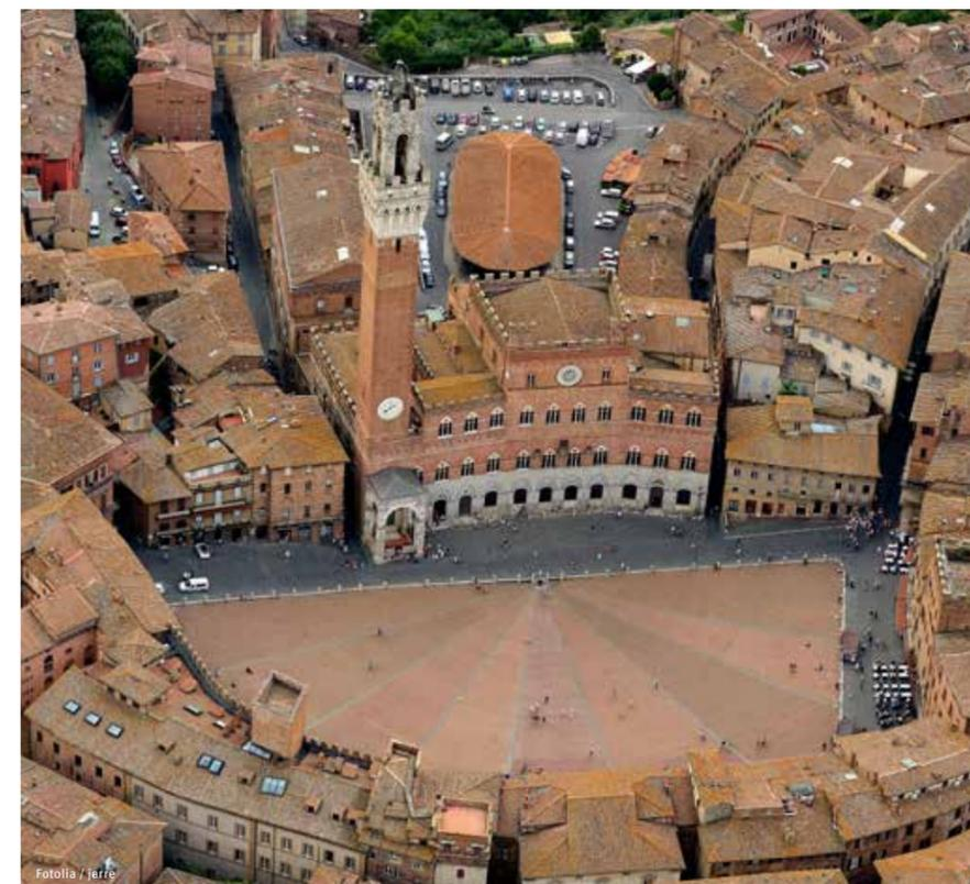
La structure radiale de la Place de Sienne a pour principal objectif un drainage favorable. L'eau coule dans le point inférieur central du coquillage qui y est aménagé.
