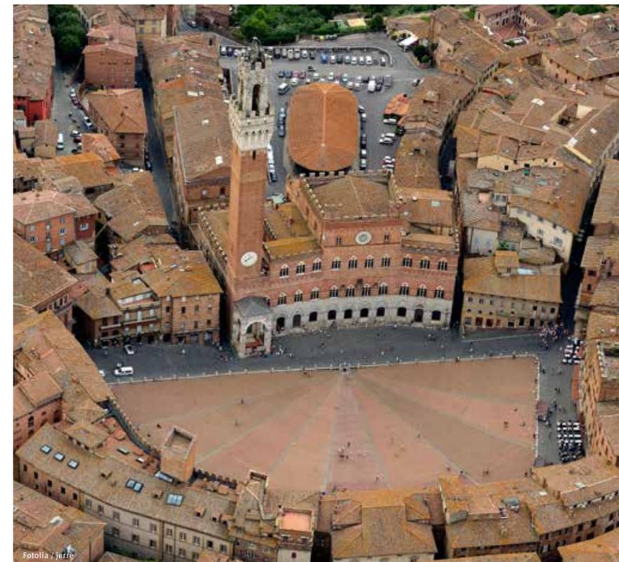
Die radiale Struktur des Platzes von Siena dient an erster Stelle einer günstigen Entwässerung. Das Wasser fließt im zentralen unteren Punkt in die dort angeordnete Muschel hinein.
