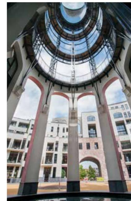
Il achemine la lumière du soleil jusqu'à l'étage inférieur du garage souterrain avoisinant en passant par l'intérieur de la tour et apporte de manière non conventionnelle la lumière naturelle sous la terre. Dès que le soleil se couche, la partie du miroir s'oriente vers le bas et est éclairé par des projecteurs. Cela permet également d'assurer l'éclairage du garage souterrain durant la nuit.
