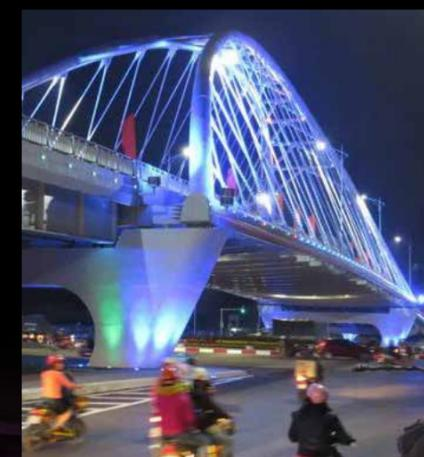
La partie intérieure du pont à haubans est éclairée par des projecteurs Powershine MK2 S RGBW, à « simple » bande LED. Pour souligner les tubes d'acier qui relient les deux arches, quelques unités du modèle Jade 9 RGB ont été installées dans la partie supérieure du pont, en utilisant des dispositifs de fixation spéciaux.
