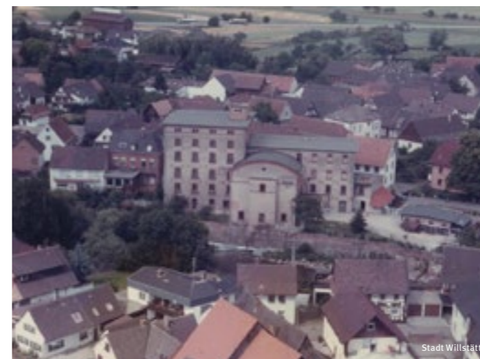
Vor der Sanierung: Das marode Mühlengebäude sowie der ungenutzte Außenraum.
