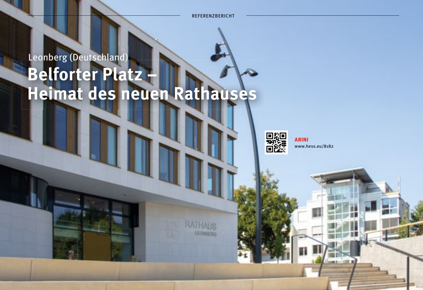
Das neue, hochmoderne Rathaus am Belforter Platz ist neuer Sitz der Stadtverwaltung von Leonberg.
