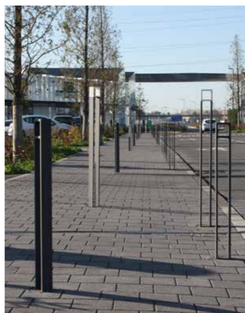
Die Absperrpoller erfüllen die hohen Sicherheitsanforderungen – und fügen sich dabei perfekt in die Umgebung ein.
